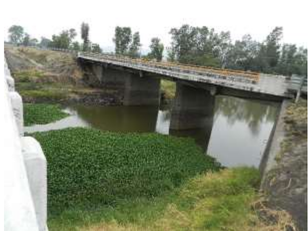
Río Turbio, Puente Irapuato-Pénjamo, Gto. (junio 2019).
